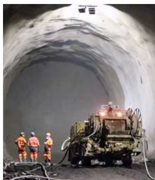
Die Arbeiten am Mont-Cenis-Basistunnel (57,5 Kilometer) sind in vollem Gang. Bild: Roland Arnet
